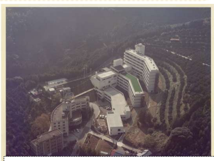
昭和52年 長寿園航空写真 工事中
